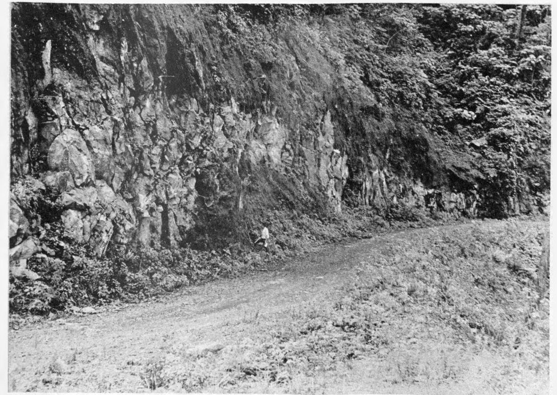
Foto 2. Aspecto de los derrames al lado de la pista Tlanchinol-Huejutla.
