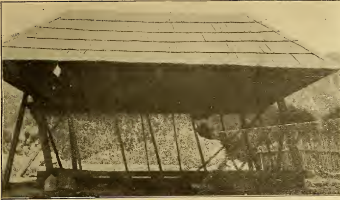
Fotografía número 1.—Caseta de madera en la plaza de Patlanalá, Pue. (Desviada en conjunto al W.)
