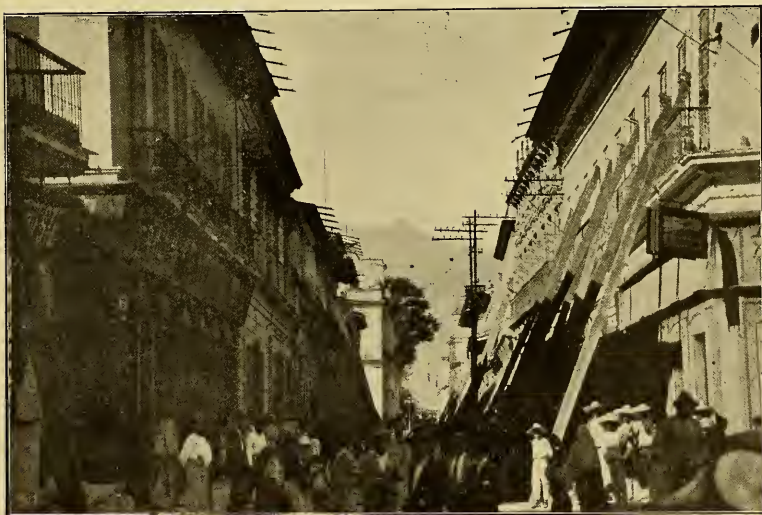
Fotografía número 2.—Jalapa, Ver. Casas apuntaladas en la calle de Enríquez. En el fondo se ve la cima del Cofre de Perote.
