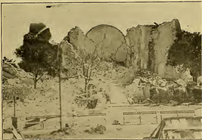
Fotografía número 2.—Iglesia destruida en Cosautlán, Ver. El muro del fondo estaba orientado NE.-SW.
